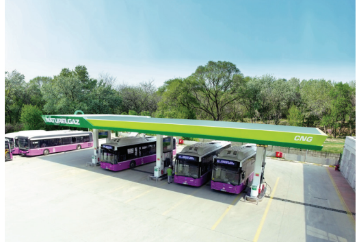
İstanbul / Alibeyköy Oto CNG İstasyonu
