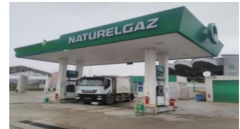
Bolu Oto CNG İstasyonu
