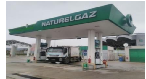
Bolu Oto CNG İstasyonu
