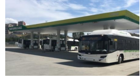
Istanbul / Alibeyköy Oto CNG İstasyonu
