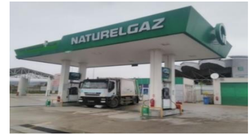
Bolu Oto CNG İstasyonu
