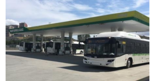
Istanbul / Alibeyköy Oto CNG İstasyonu
