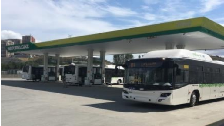
Istanbul / Alibeyköy Oto CNG İstasyonu
