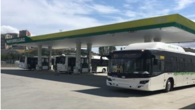
Istanbul / Alibeyköy Oto CNG İstasyonu
