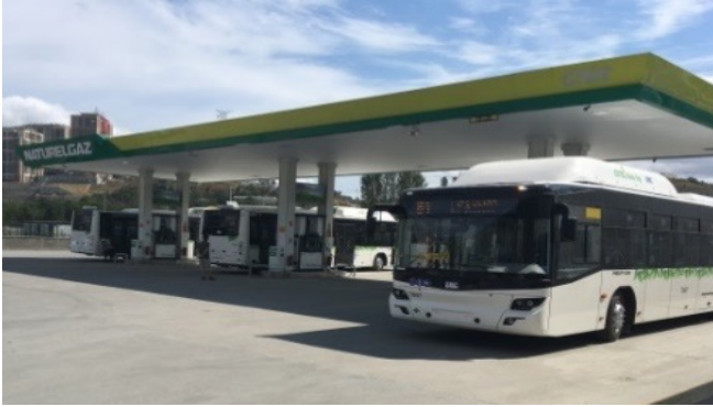
Istanbul / Alibeyköy Oto CNG İstasyonu
