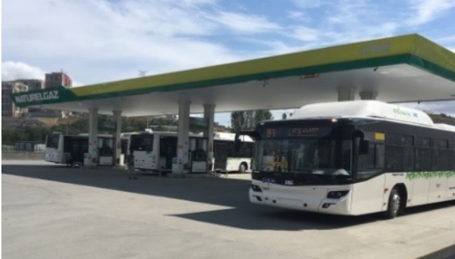
Istanbul / Alibeyköy Oto CNG İstasyonu
