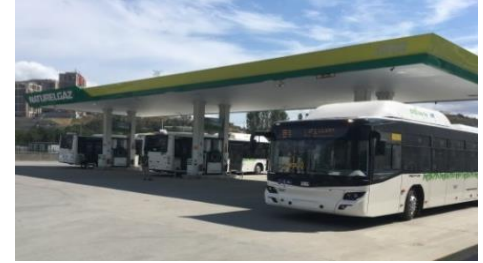
Istanbul / Alibeyköy Oto CNG İstasyonu
