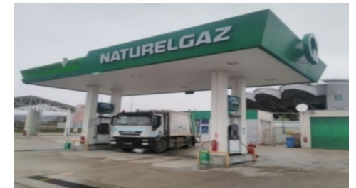
Bolu Oto CNG İstasyonu
