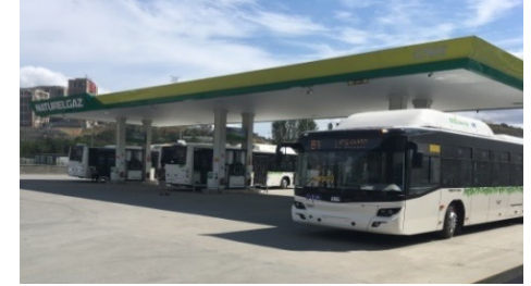
Istanbul / Alibeyköy Oto CNG İstasyonu
