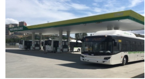
Istanbul / Alibeyköy Oto CNG İstasyonu
