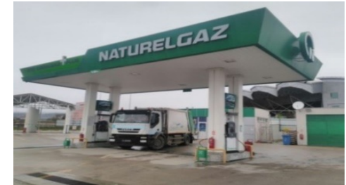
Bolu Oto CNG İstasyonu
